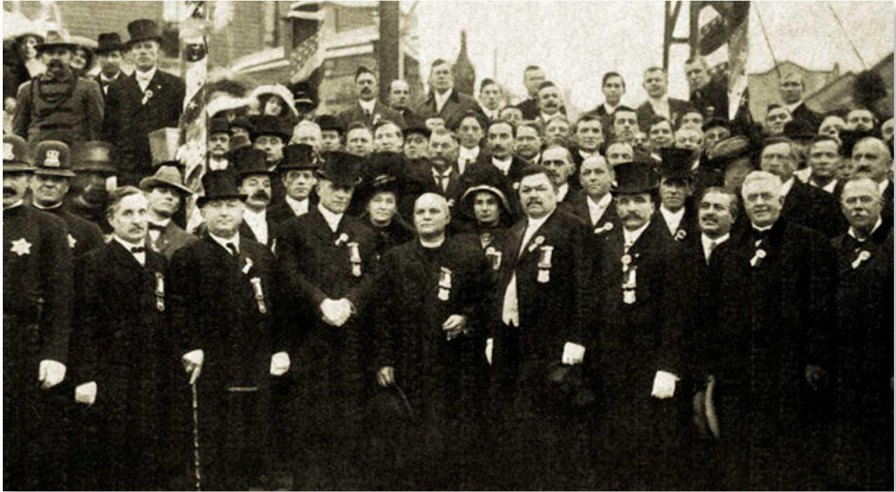
The consecration of the cornerstone of the PRCUA building in 1912 Uroczystość poświęcenia kamienia węgielnego pod budynek PRCUA w 1912 r.
